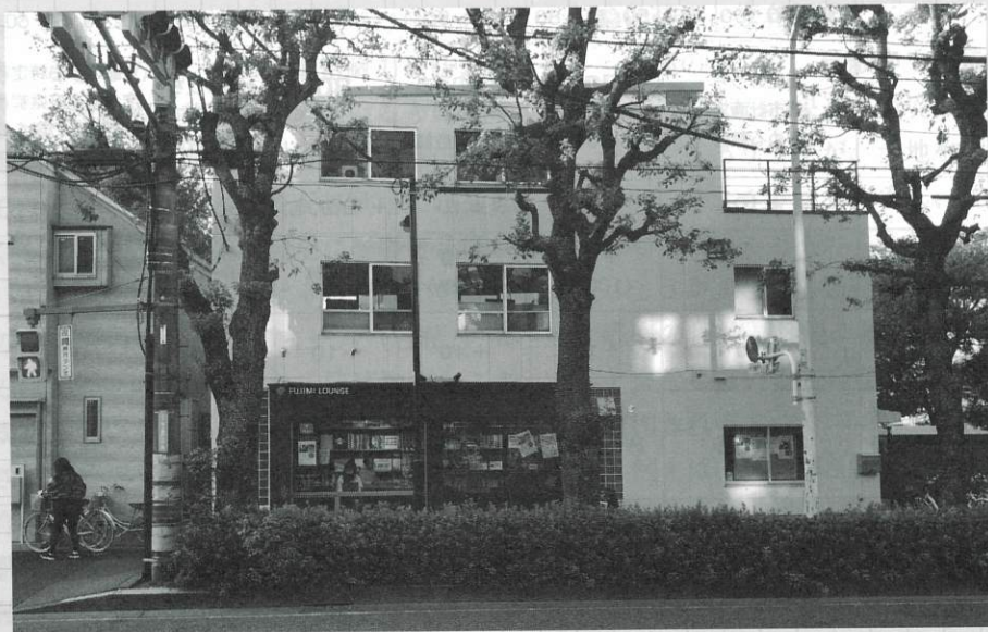
写真2 FUJIMI LOUNGEを道路側から見る
