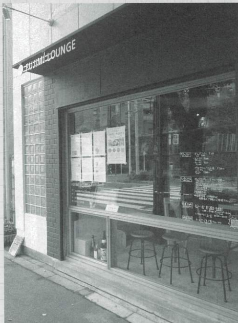
写真3 大きなガラスの開口部
